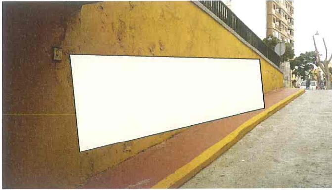
Salida de aparcamiento.
